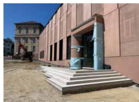
Die Treppenstufen vor dem neuen Tapetenmuseum sind gesetzt.
