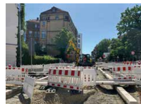
Die Weinbergstraße ist Schwerpunkt in der aktuellen Bauphase.
