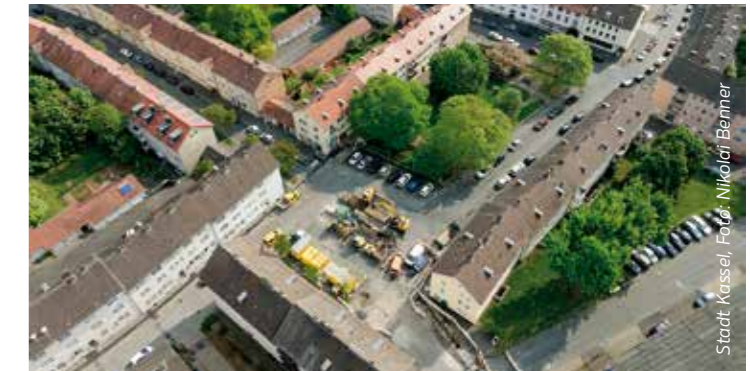
Der Quartiersplatz Pferdemarkt im Jahr 2022 – eine Luftaufnahme zeigt den Platz vor seiner Neugestaltung.
