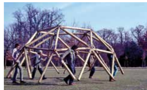
Low Cost Bauen: hier eine Bambusgitterschale von 1982.
