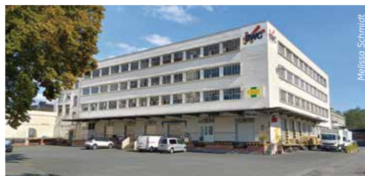
An der Hafestraße 76 eröffnete die BauMaB diesen März ihren ersten Lagerstandort und lädt zum Entdecken ein.
