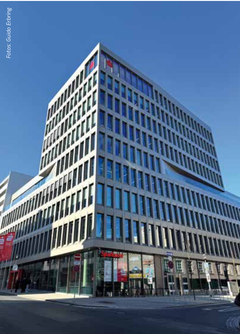
Vereint alle Leistungen unter einem Dach: Der Neubau der Kasseler Sparkasse in zentraler Innenstadtlage.
