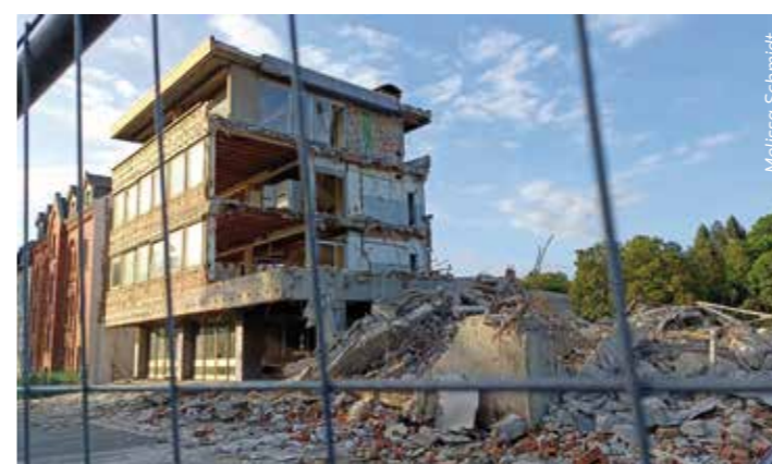
Abrissprojekte machen Ressourcenverschwendung eindrücklich erlebbar, wie hier im Sommer 2024 in der Fiedlerstraße.
