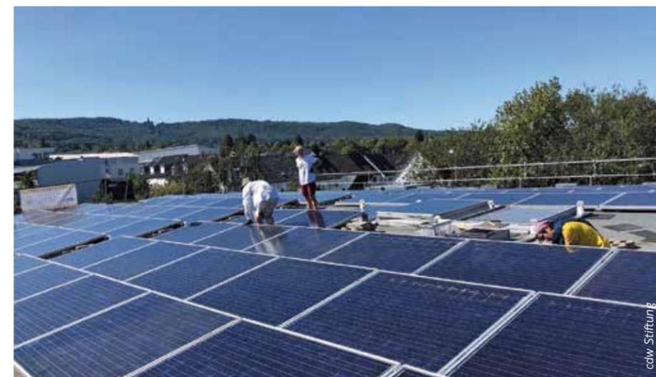
Zubau von Photovoltaik: Gerade in der Stadt ist es wichtig, die Dachflächen zu nutzen, um Strom aus regenerativen Quellen zu erzeugen. Hier im Bild: das Team von SoLocal Energy bei der Montage einer PV-Anlage auf dem Dach des Kinder- und Jugendzentrums Rambazotti auf der Marbachshöhe.
