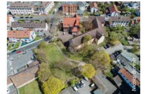
Der Hochbunker Agathof in seiner Struktur eines landwirtschaftlichen Anwesens, links daneben das Stadtteilzentrum Agathof und davor die Freifläche, die zum Mehrgenerationenpark wird.
