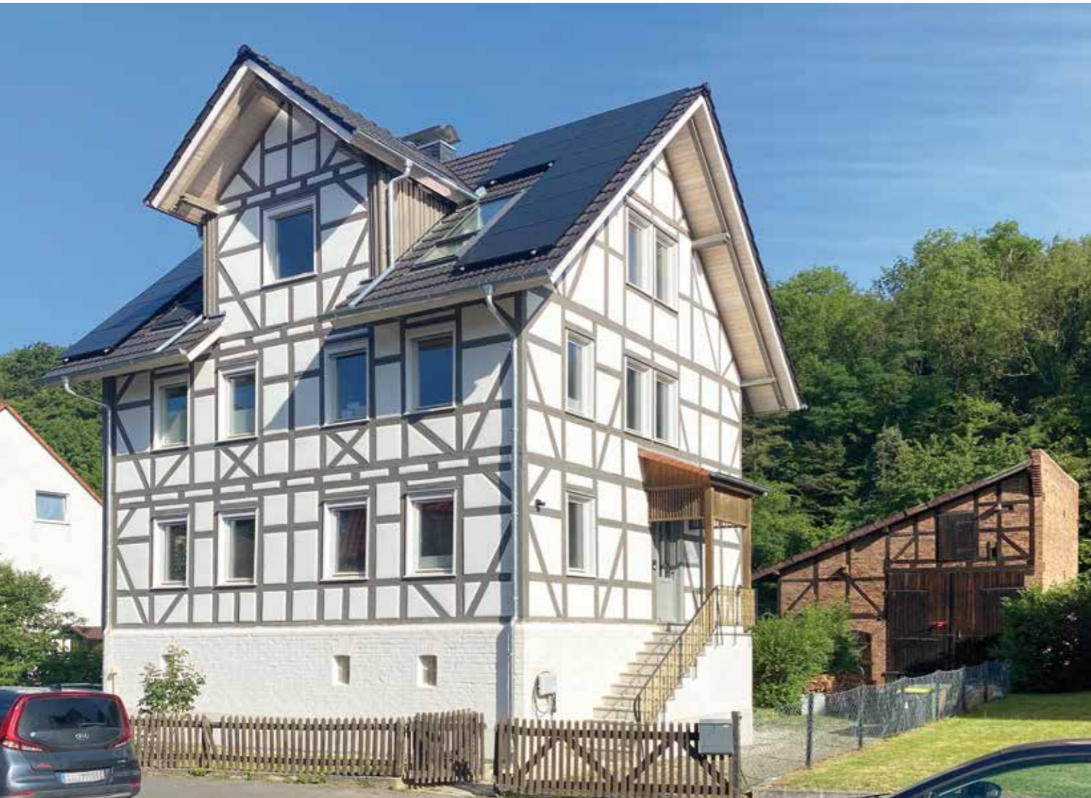
Ansicht des denkmalgeschützten Fachwerkhouses nach der Sanierung.
