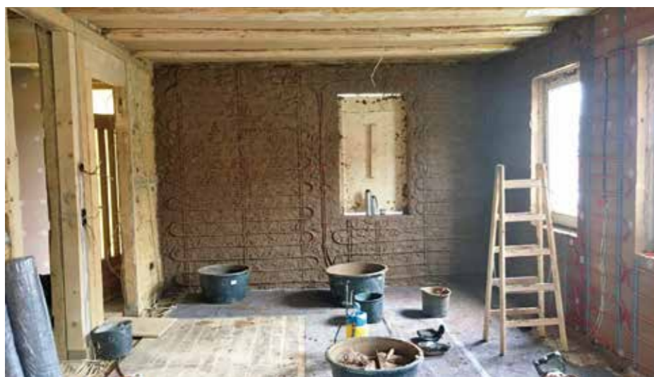
Rückbau auf die Rohbaustruktur aus dem Jahr 1912.
