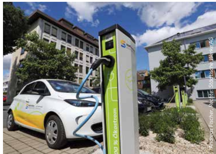
Sauber, leise, modern – und förderfähig. Ein Elektrofahrzeug an einer Ladesäule bei den Städtischen Werken im Kasseler Königstor.
