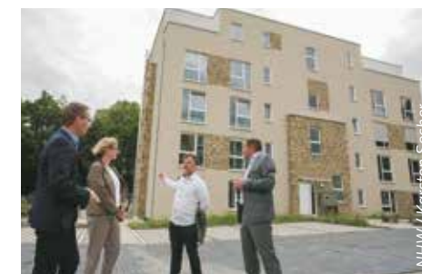
Fertig und bereits bezogen: Das Projekt am Felsenkeller im Stadtteil Fasanenhof.
