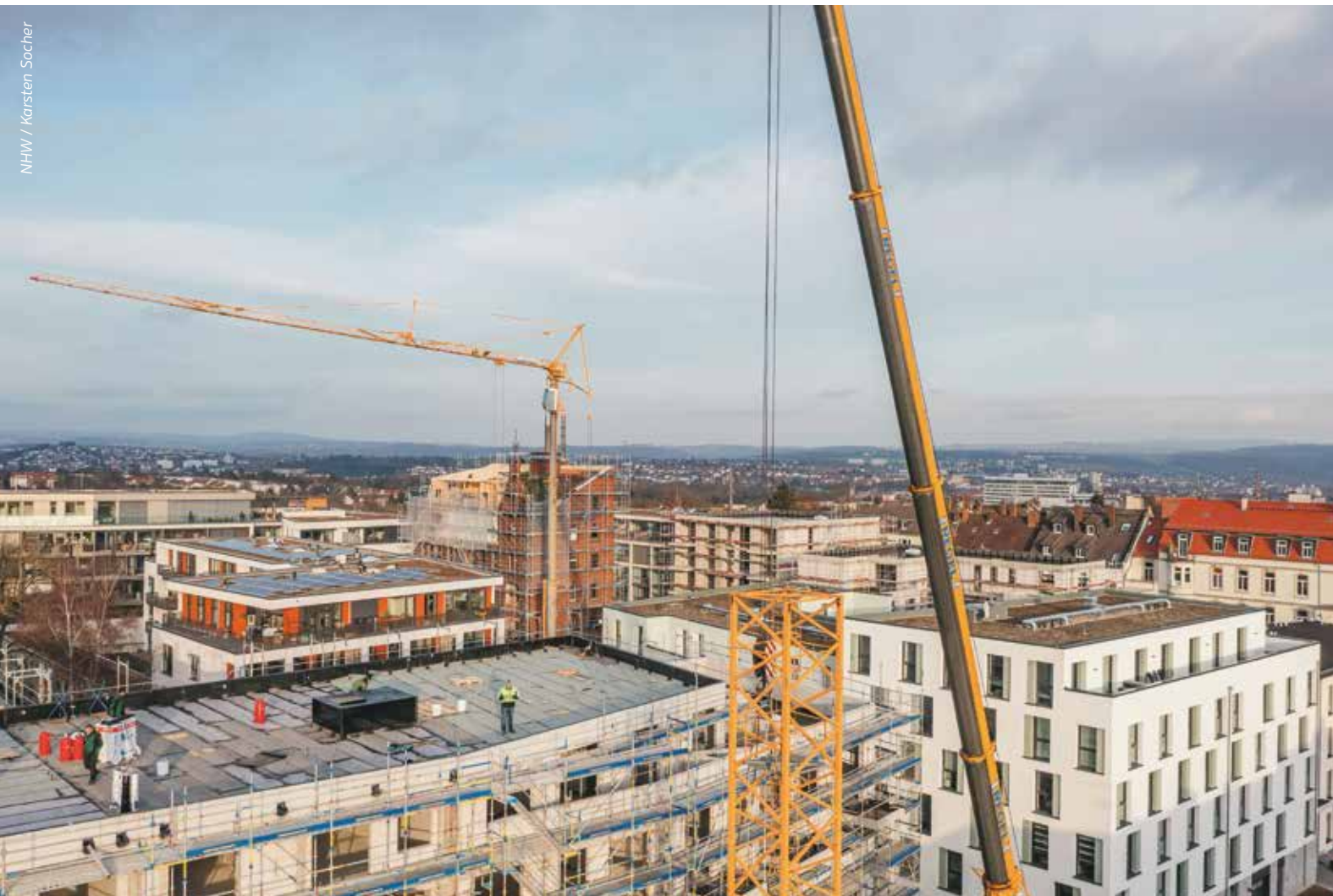
Das MartiniTor bildet das Entrée zum neu entstehenden Martini-Quartier. Im Winter 2022/23 wird es fertig. Der große Kran ist bereits nicht mehr auf der Baustelle.
