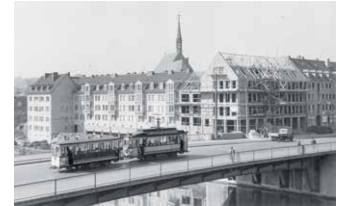
Blick über die Fuldabrücke in der Wiederaufbauzeit.
