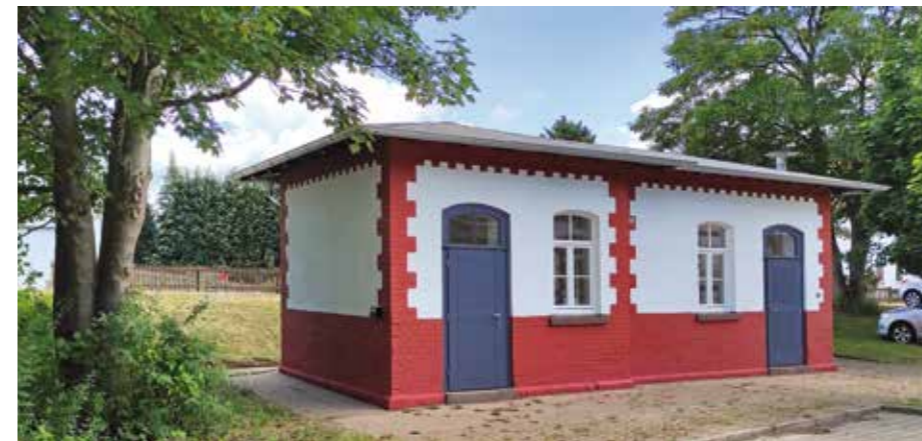
Dank der denkmalgerechten Sanierung ist das gesamte Bahnhofsensemble heute ein lebendiges Zentrum für Jung und Alt.
