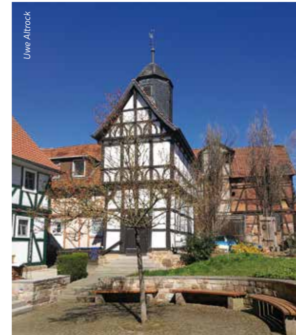
Klassische Baustruktur im Fachwerkstil, wie sie in nordhessischen Ortskernen oft zu finden ist.
