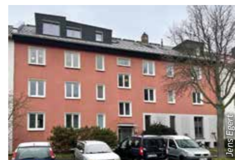
In diesem Haus, Blücherstraße 34, ermöglichte das Förderprogramm dem Eigentümer, die Fenster zu erneuern, was zu einer Vereinheitlichung der Straßenfassade beitrug.
