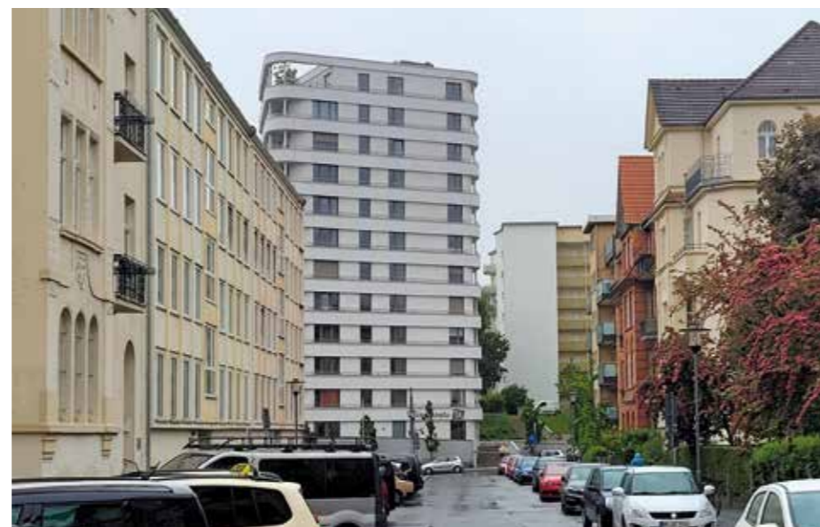
Hochpunkten in der Stadt, wie hier an der Westendstraße, sollte wegen ihrer besonderen Wirkung im Stadtraum eine besondere gestalterische Aufmerksamkeit zu Teil werden.
