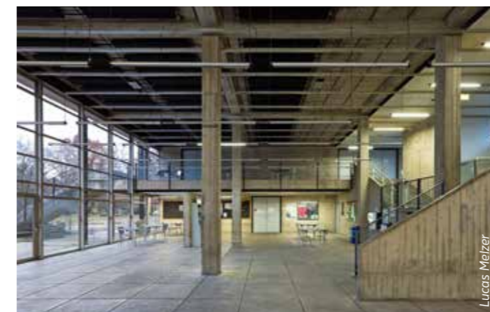
Atrium mit filigraner Glasfassade und markanter Stahlbeton-Konstruktion.
