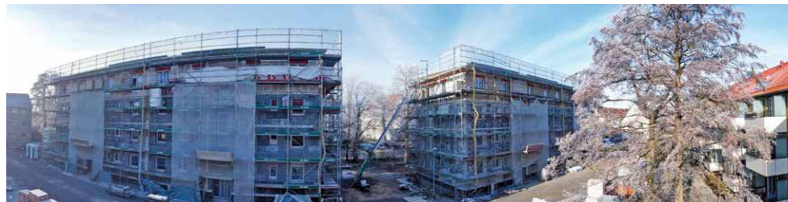
Eine Etage extra: Die Unternehmensgruppe Nassauische Heimstätte | Wohnstadt modernisiert in Kassel-Harleshausen 42 Wohnungen und errichtet 14 neue durch Aufstockung. Foto: NHW / Möller
