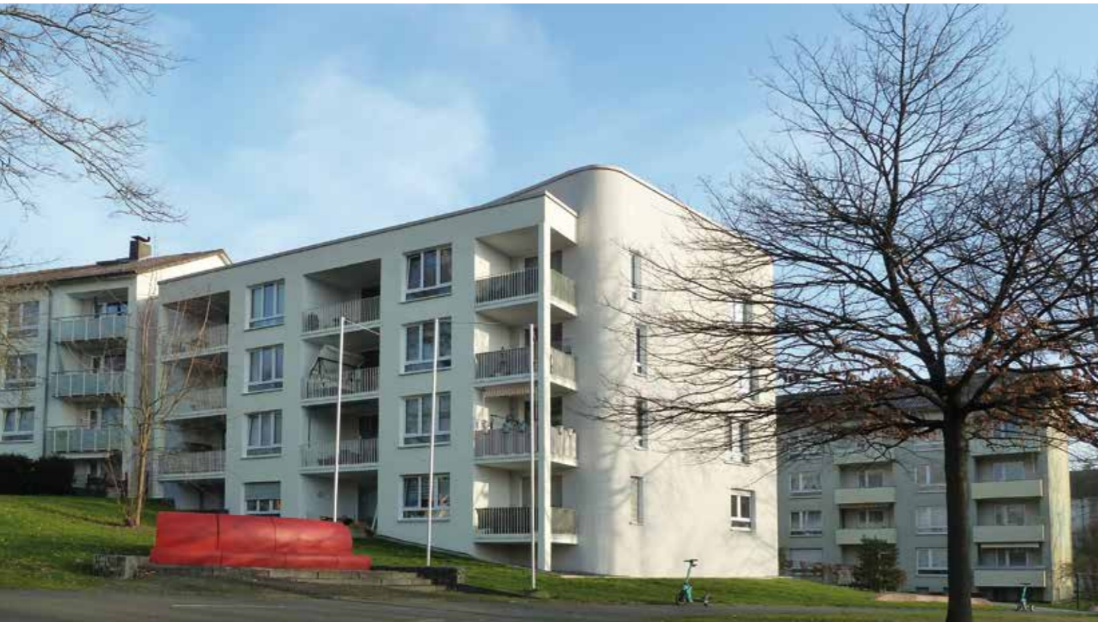
Großwohnsiedlungen aus den 1950er- bis 1970er-Jahren stellen ein häufig unterschätztes Potential der Innenentwicklung dar. In Helleböhn hat die GWH eine sensible Nachverdichtung mit einer Aufwertung der Freiflächen verbunden.
